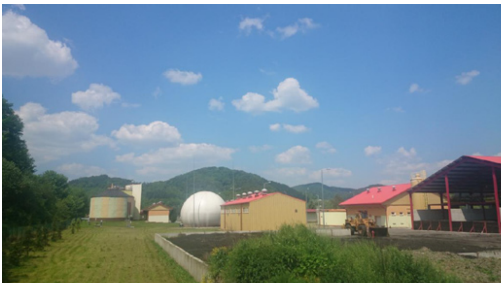
Rys. 2. Widok na część technologiczną przeróbki osadów
