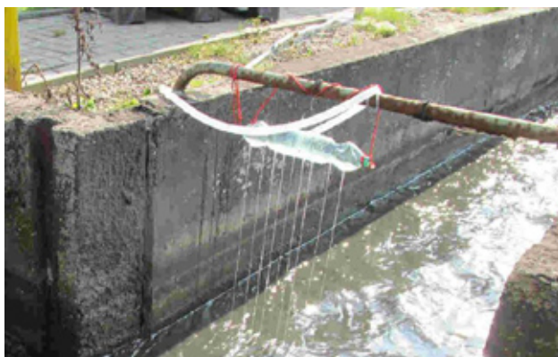
Fot. 2. Instalacja do dozowania polielektrolitu A110 do komory rozdziału przed osadnikami wstępnymi w trakcie badań w oczyszczalni Słupsk
