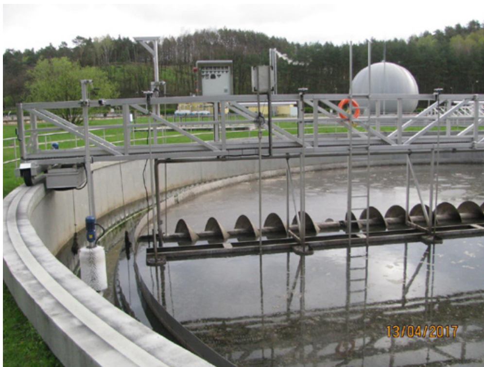
Zdjęcie 4. Efekt stosowania PAX-18. Powierzchnia osadnika wtórnego bez flotu.
