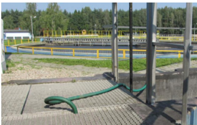
Fot. 1. Dozowanie PIX-113 do kanału przed piaskownikiem
