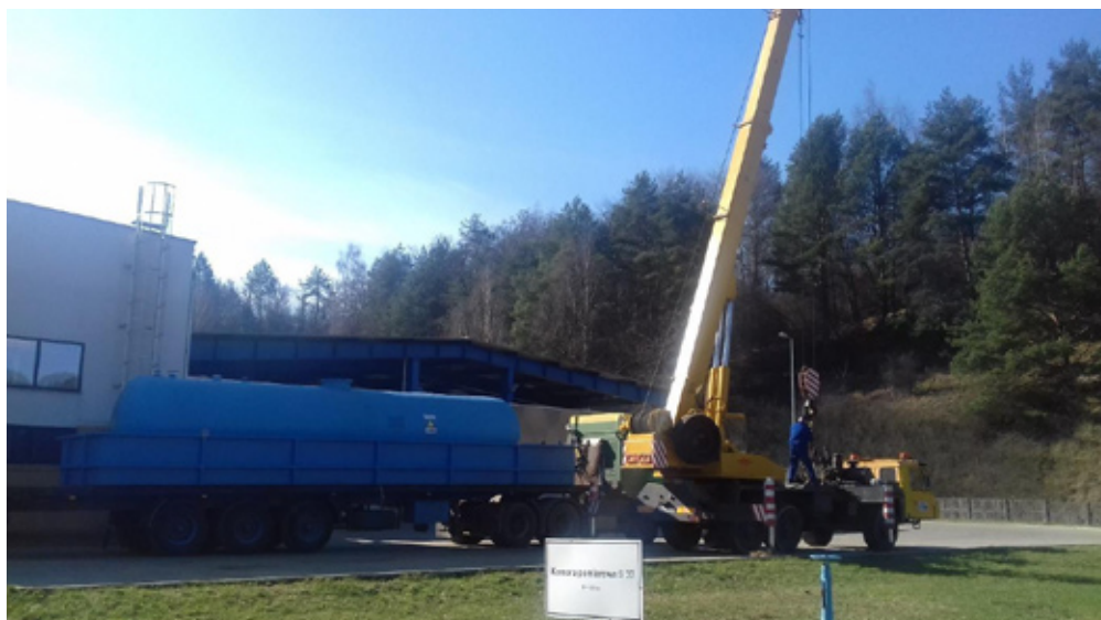
Zdjęcie 3. Montaż układu dozowania PAX-18
