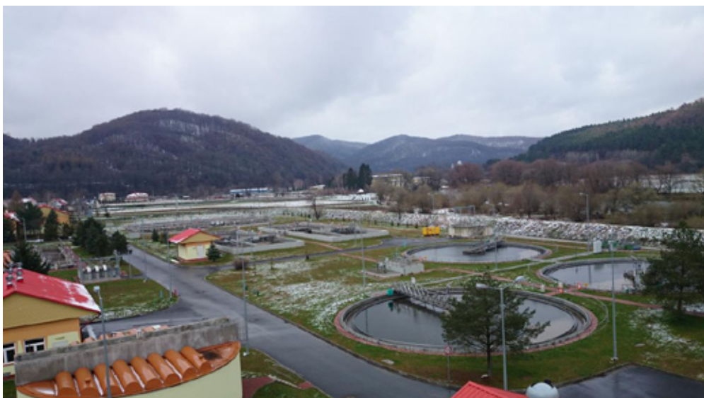
Rys. 1. Widok na reaktory biologiczne i osadniki wtórne
