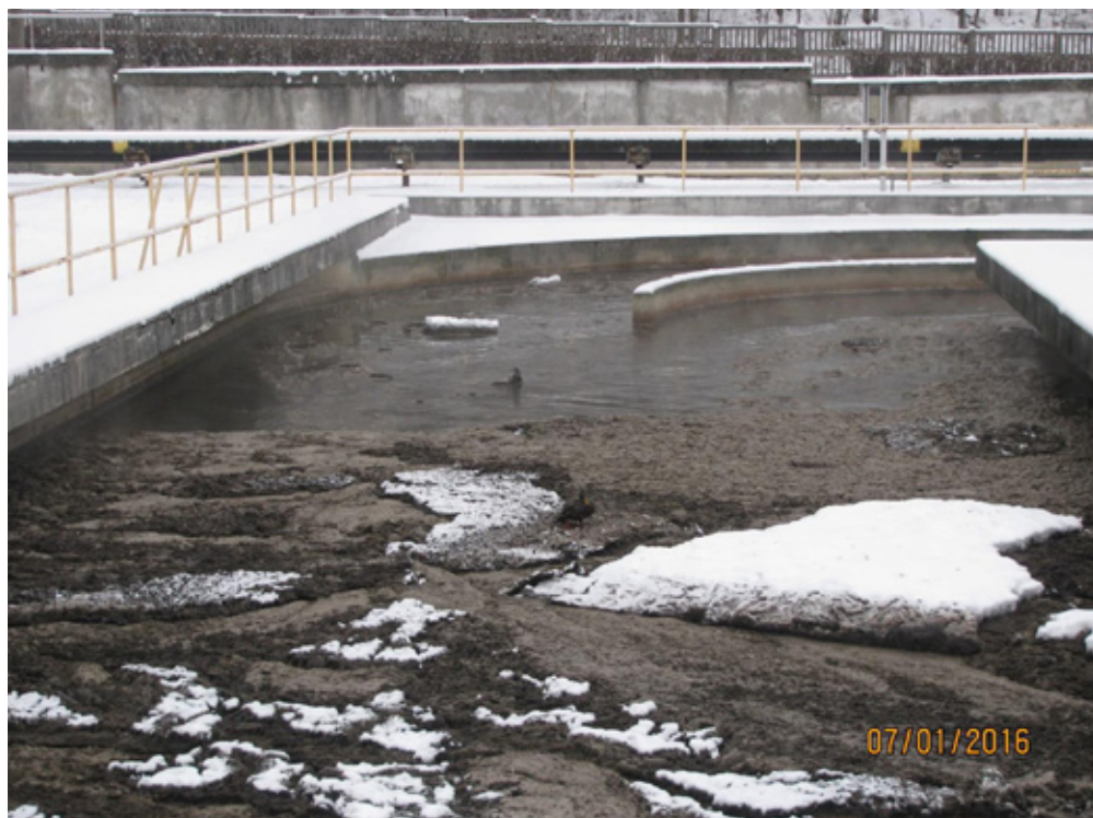
Zdjęcie 1. Przed stosowaniem PAX-18. Reaktor biologiczny pokryty zamarzającym flotem.
