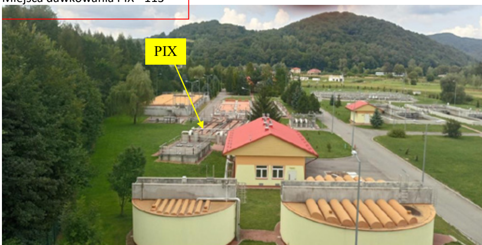
Rys. 4–6. Instalacja do dozowania PIX – 113 i miejsca dawkowania PIX
